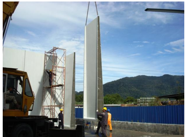
(d) Lifting and Mounting of Wall.
