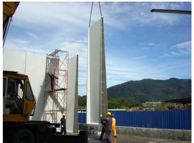
(d) Lifting and mounting of wall
